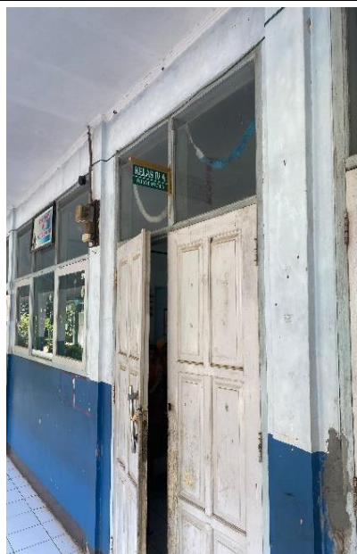
Ruangan Kelas IV SDN 1 Mekarjadi
